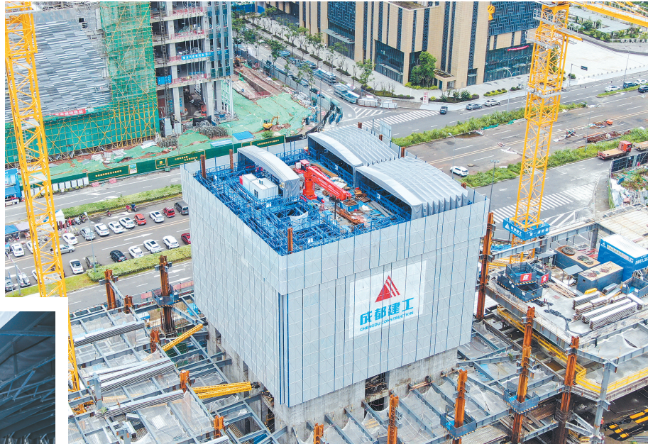
已搭建完成的智能化一站式施工建造平台
