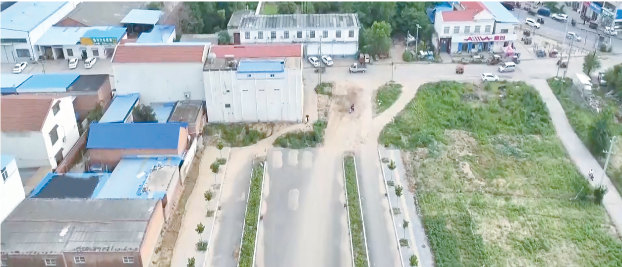
在魏庄安置房配套项目中，当地要修建一条约560米的道路。可至今，这条路仍然是“断头路”，还有200多米没有修通
