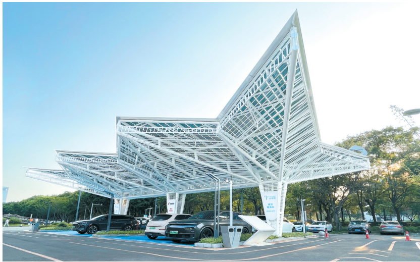
“光储充放”一体化停车场
