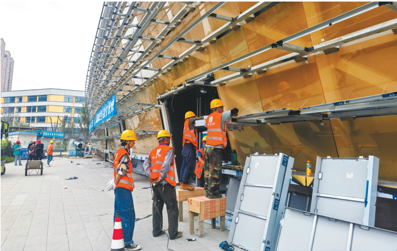
金沙演艺综合体项目施工现场
