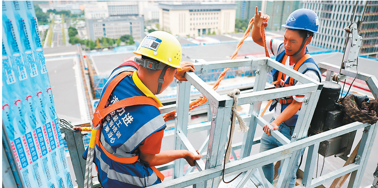
成都芯谷金融中心项目施工现场
