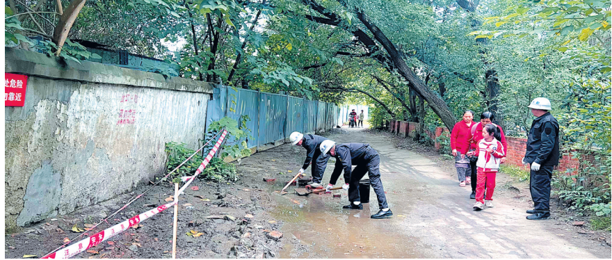
施工人员清除道路积水
