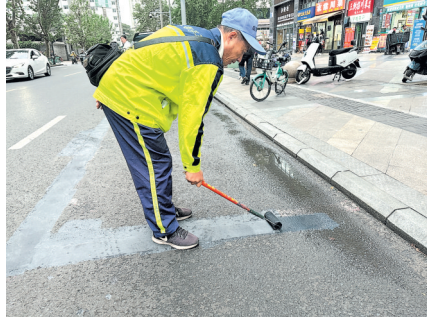
取消停车位,为公交车停靠留足位置
