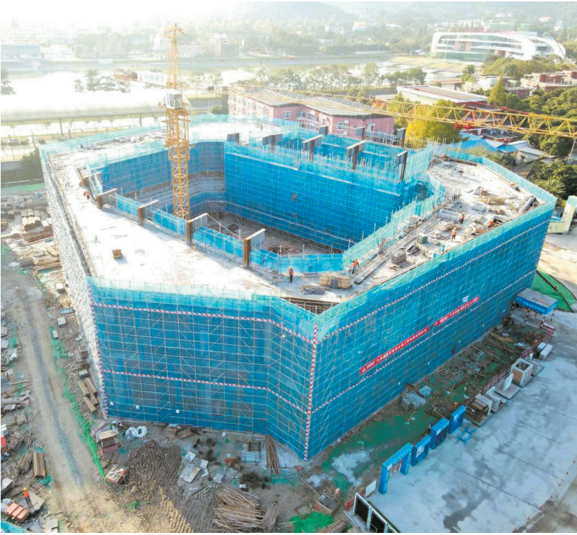
四川省体育运动学校项目加快建设
