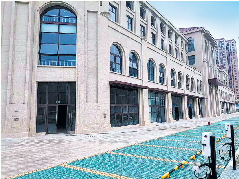
天和西八广场社区综合体项目已经完工,即将验收。
