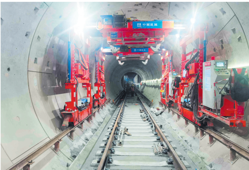
工程车正在铺轨
