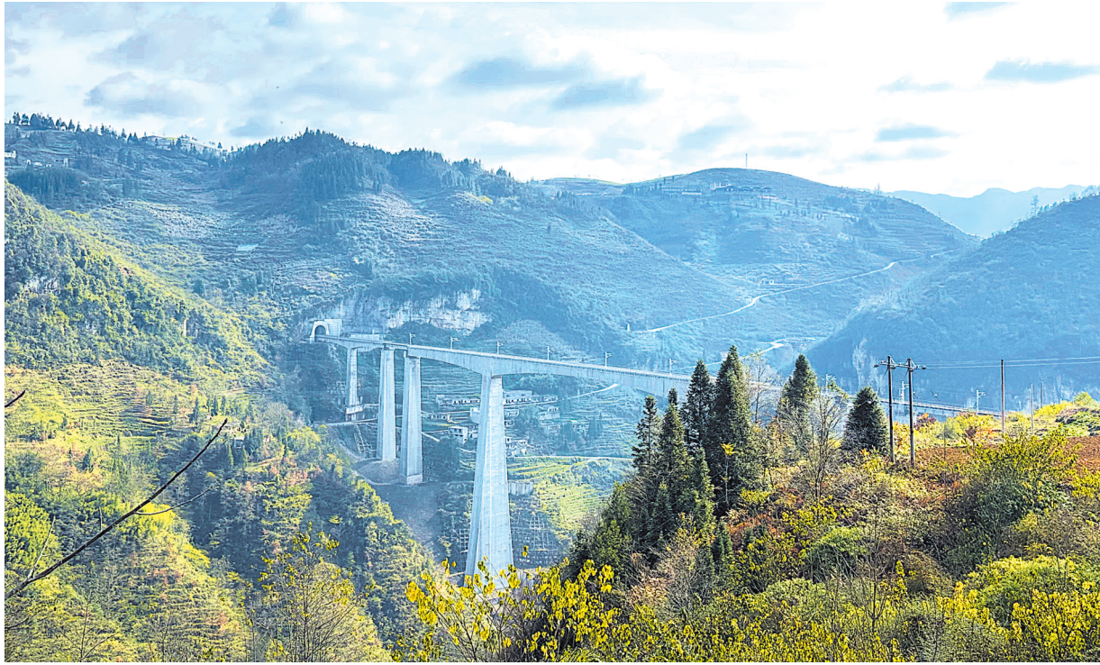
冯家寨特大桥
