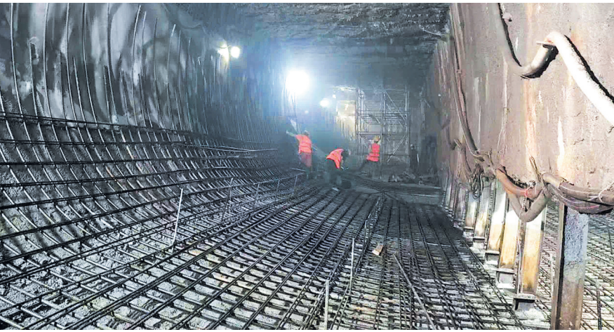
18号线三期驷马市站主体结构施工现场。
