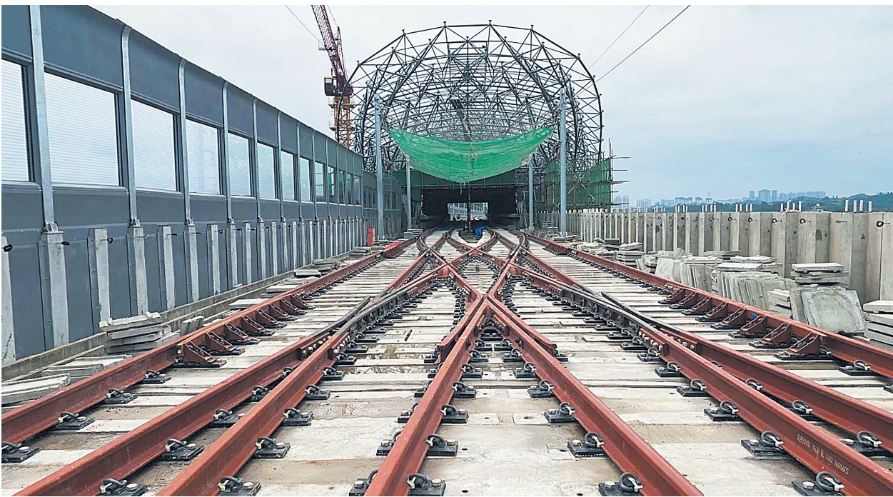
资阳线临空经济区站建设现场
