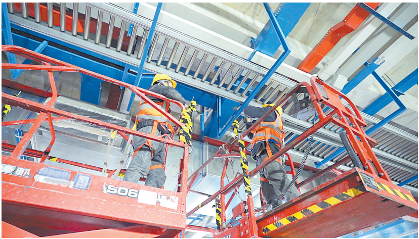
华西医院锦江院区施工现场。
