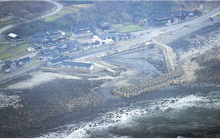
石川县珠洲市海岸1月6日航拍图
