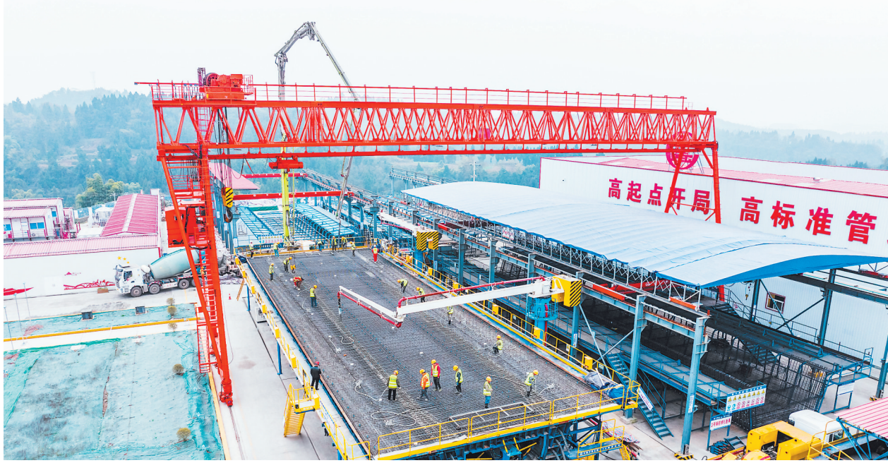
成渝中线高铁建设现场一派繁忙景象 国铁成都局集团供图
