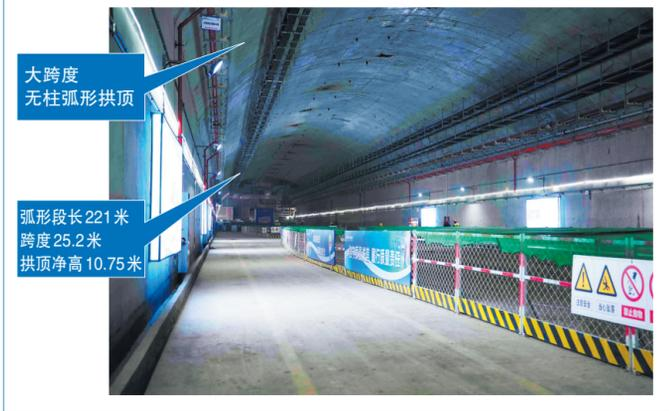
另据施工人员介绍,车站基坑平均深度约30米,相当于10层楼的高度。车站为12米岛式车站,主体总建筑面积为47833.4平方米,相当于6.5个标准足球场的面积。
