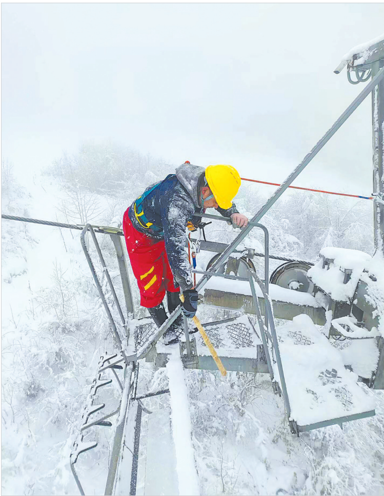
西岭雪山空中索道安全员开展索道安全检查
