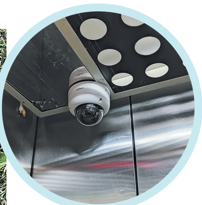
阻车器依托电子监控,杜绝电动自行车进电梯
