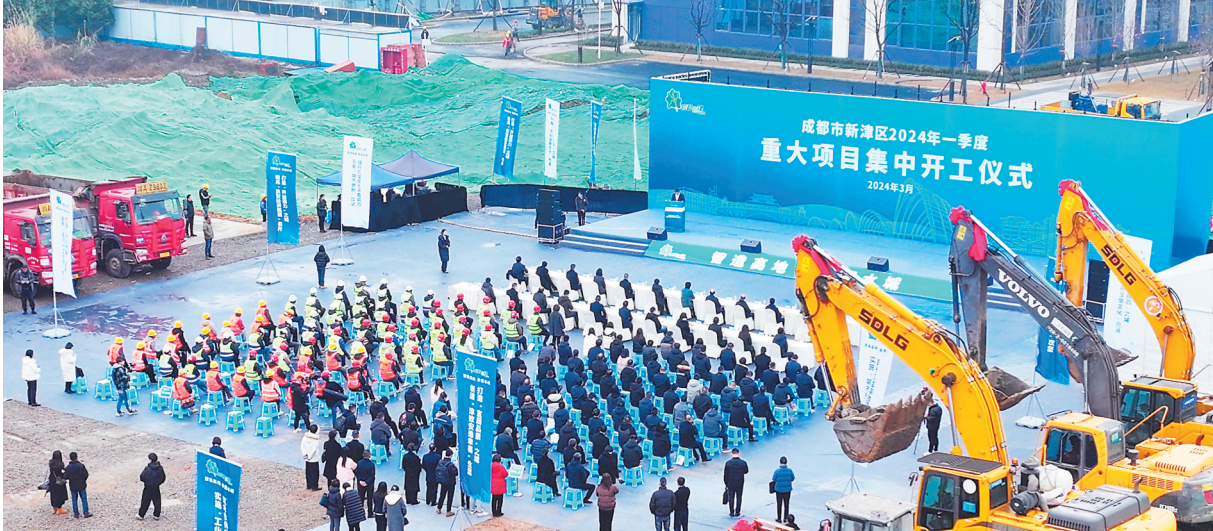
项目开工仪式现场
