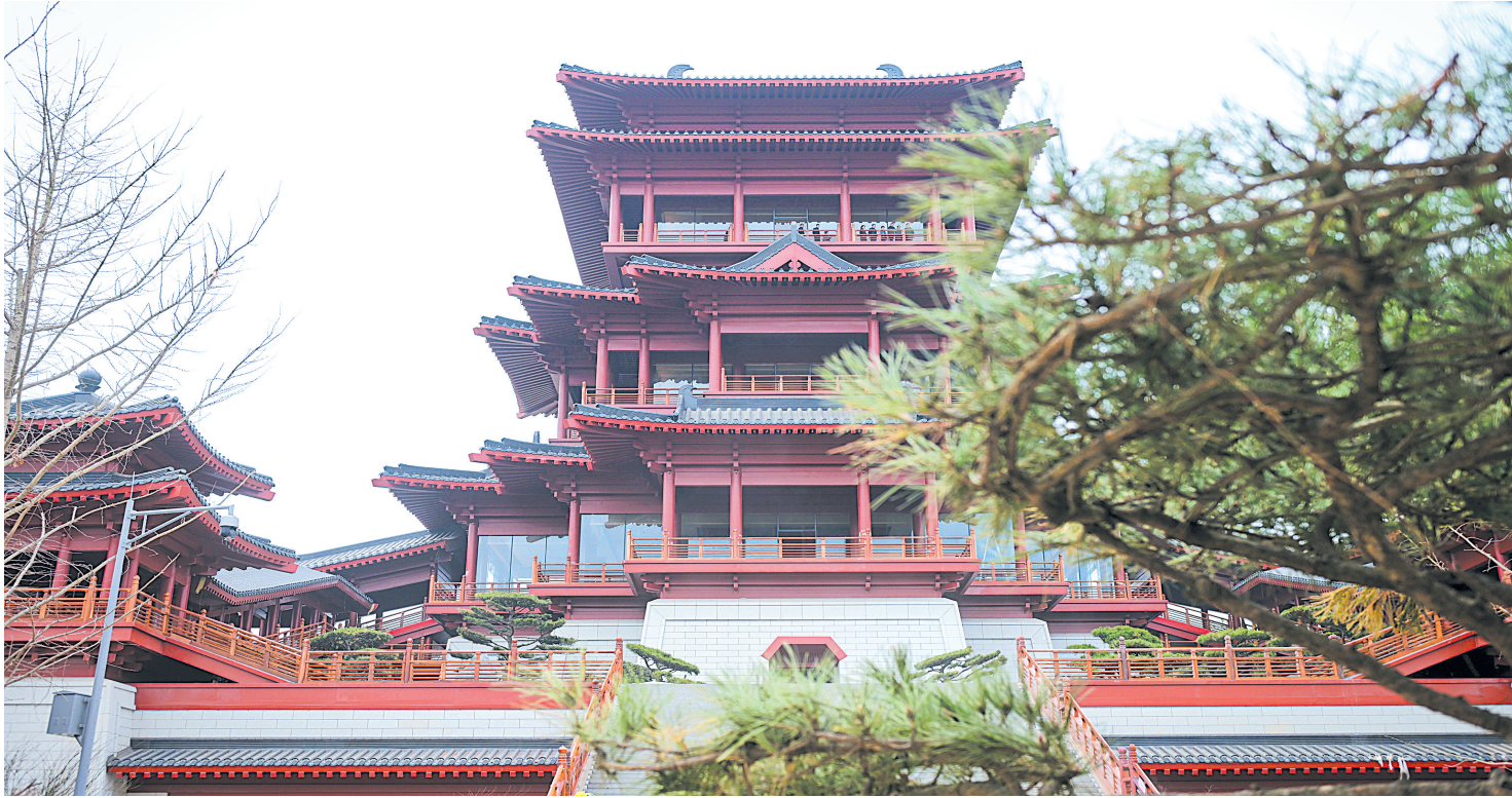
散花楼已全部完工
