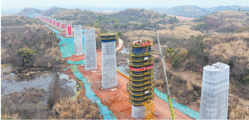
成渝中线高铁土红湾特大桥建设现场。 图据新华社
