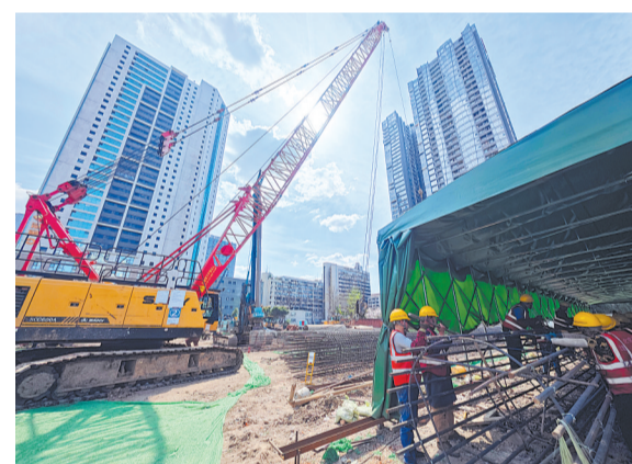
工人正在绑扎钢筋条
