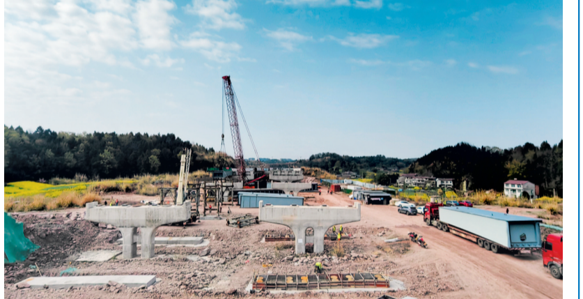
迎宾大道延长线项目建设现场
