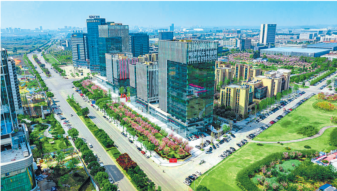
电子科大科技园(天府园)五期B区
