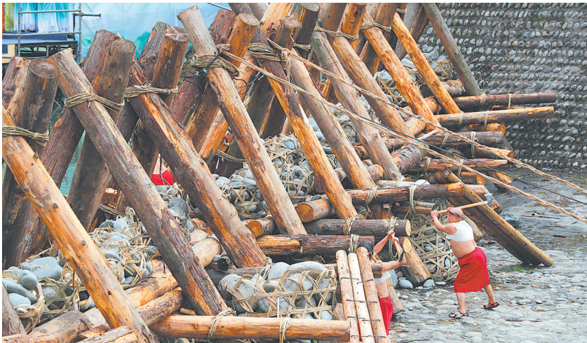
放水节现场，堰工挥动斧头砍杓槎。
