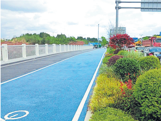
南三线跨城市绿廊桥梁工程
