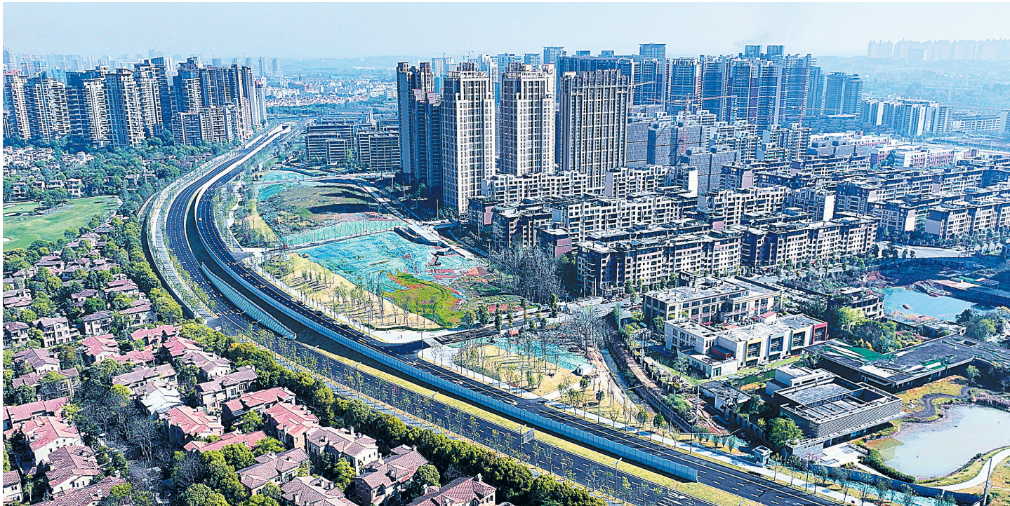
夔州大道二期（区界—沈阳路）（含下穿隧道）项目开通
