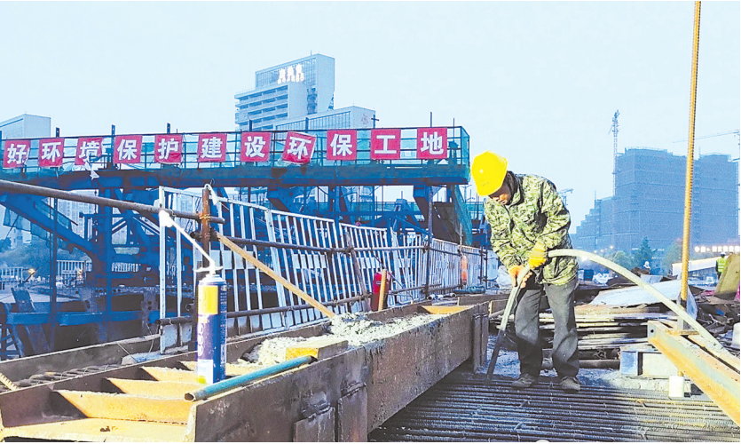
崇州大桥项目现场,工作人员正在施工
