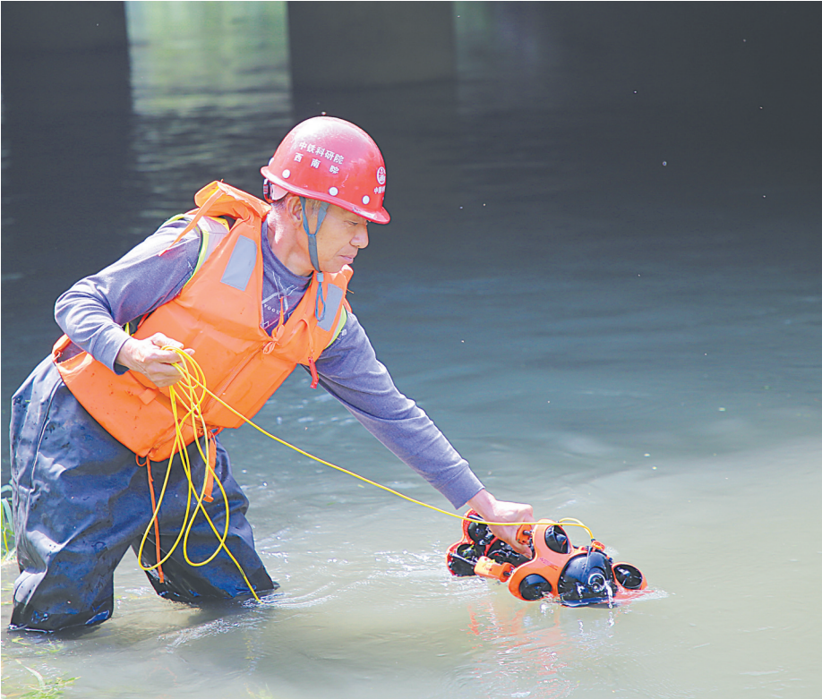
工作人员正在用水下机器人对桥梁进行检测
