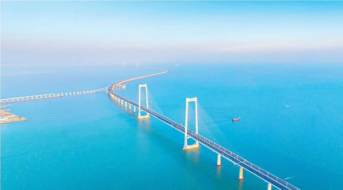
深中通道中山大桥建设现场
