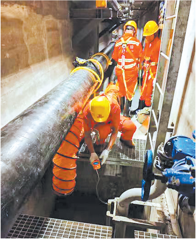
地下综合管廊应急演练
