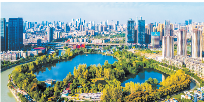
经过水生生态修复后的东湖公园。 本报资料图片
