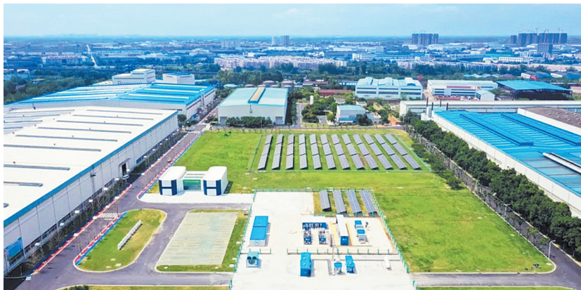
东方电气氢能科技应用示范园
