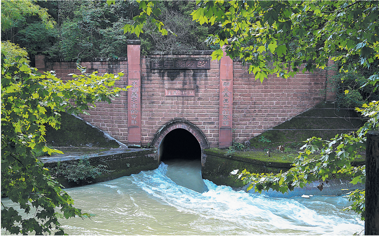
龙泉山引水隧洞出口（简阳市档案馆馆藏）
