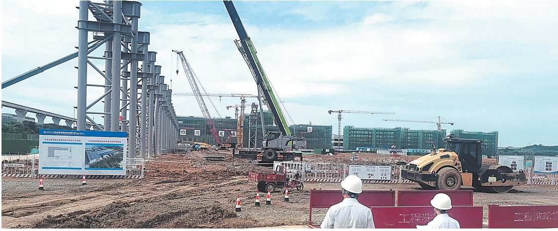
重大项目中铁高新智能装备制造基地施工现场。
