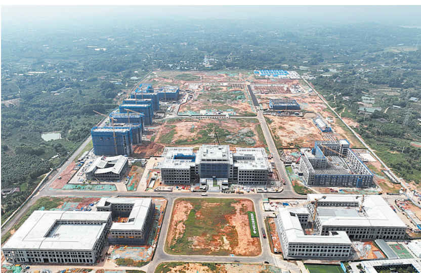
川大眉山校区项目施工现场。
