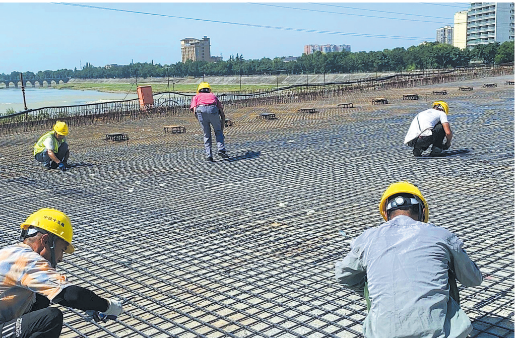
崇州大桥项目施工现场
