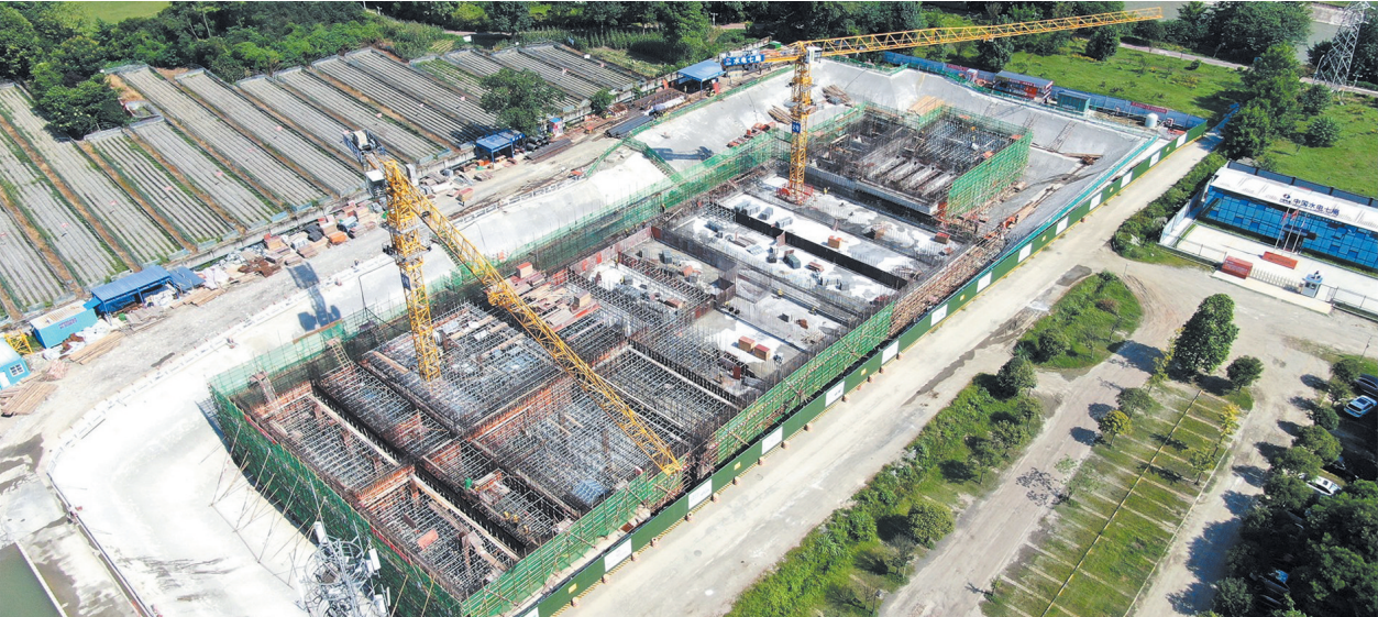
三道堰污水处理厂扩能及污水管网更新改造项目建设现场
