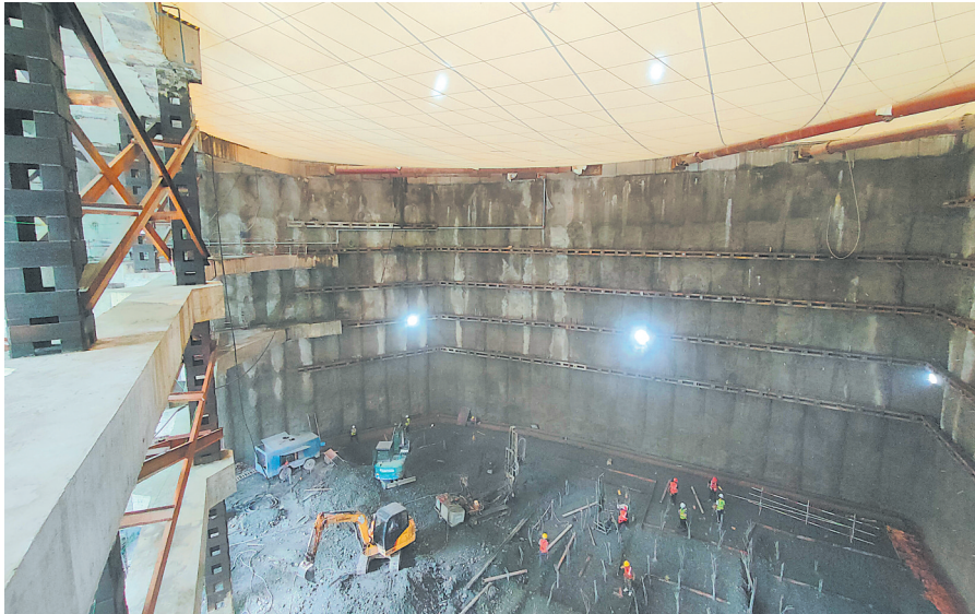
像白色“气球”一样的防晒罩罩在工地上
