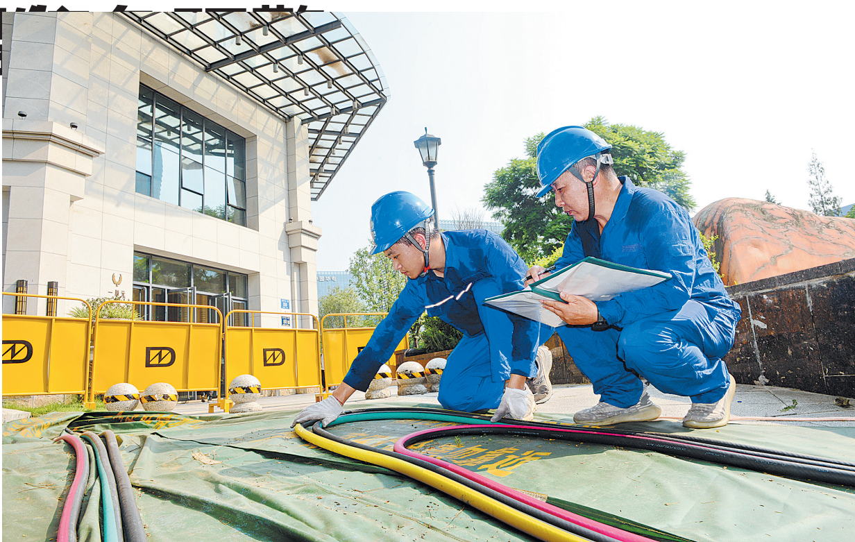
工作人员有条不紊地开展电缆施工
