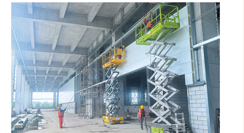
顺丰西部航空货运枢纽项目进行室内安装和幕墙施工
