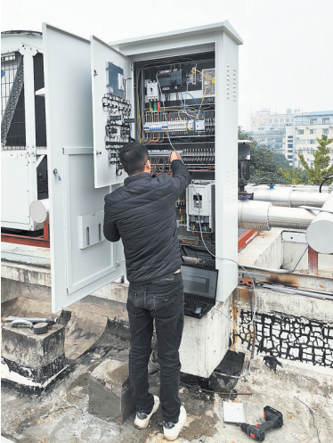
工作人员在调试安装设备
