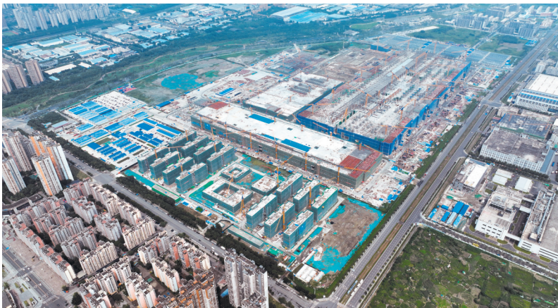
京东方第8.6代AMOLED生产线项目现场。
