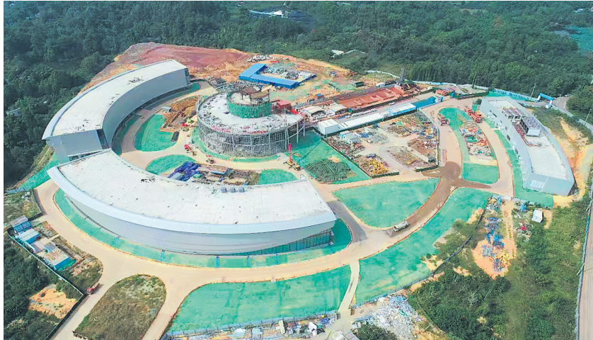
光场调控项目施工现场
