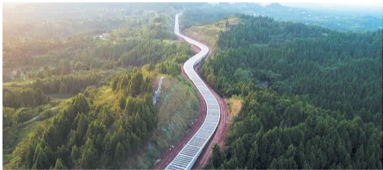
余家湾隧洞至金鸡梁隧洞明渠段施工现场
