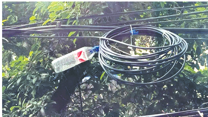
用塑料瓶遮盖裸露线缆
