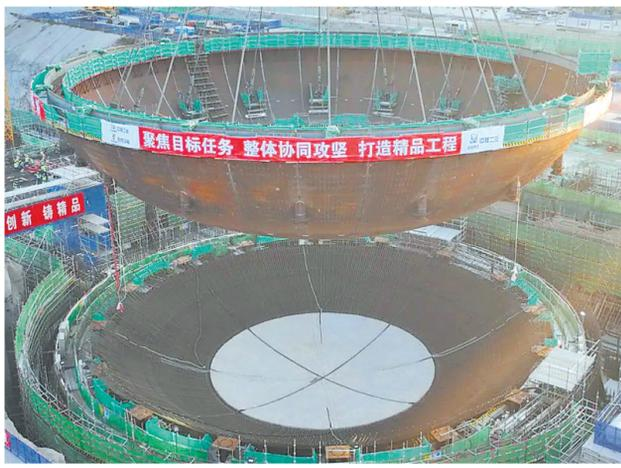
10月27日17时02分,由中国核电工程有限公司总包的徐大堡核电项目2号机组反应堆厂房钢制安全壳封头顺利吊装就位,拉开了2号机组反应堆厂房内部结构施工的序幕,标志着2号机组关键路径建造工作迈出了坚实一步。
