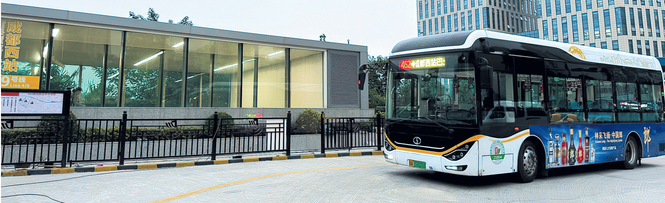
改造后，车辆停靠在港湾内，不影响主干道车辆通行
