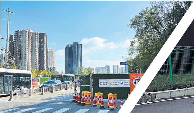
在静康路至沙河大桥段还剩下部分围挡
