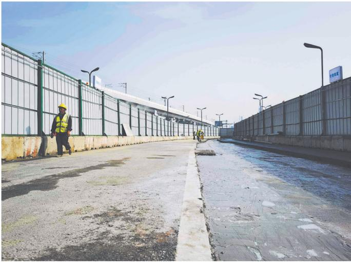
交织,严重影响成新蒲快速路进城方向的通行效率。为解决这一堵点问题,市住建局会同各相关市级部门和双流区,经过多方考量和论证,敲定了最终改造方案——改造成新蒲大道与绕城高速收费站出口合流处的侧分带84米,优化交通组织,缓解交通拥堵。
