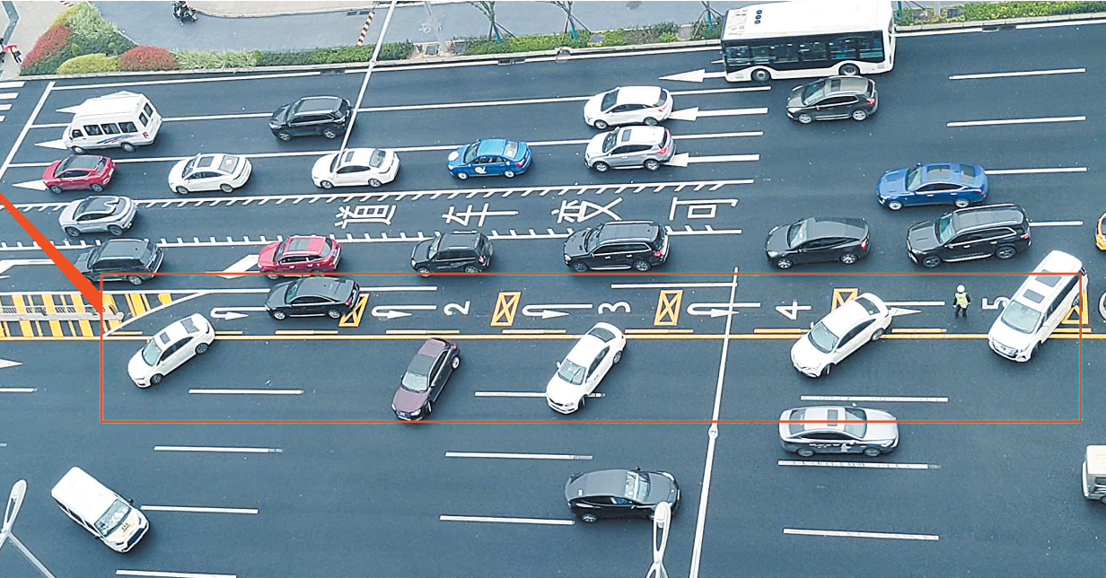
成都交警在武侯大道与聚福路交叉路口启用“多车位串联掉头”新型通道,缓解路口拥堵
