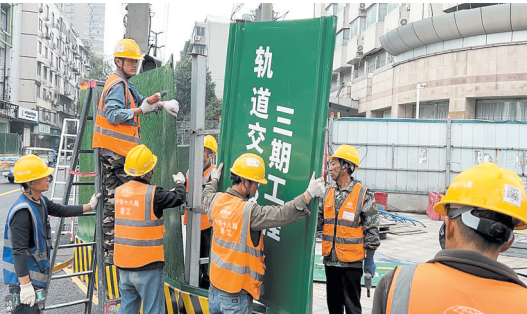
施工人员正拆除围挡
